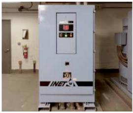
400Hz DIESEL AIRCRAFT GROUND POWER UNITS (GPUs)
